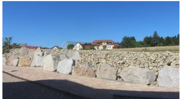
**Abb. 26:** Steinschüttungen im Bereich der Rampe/Damm (60.63)
